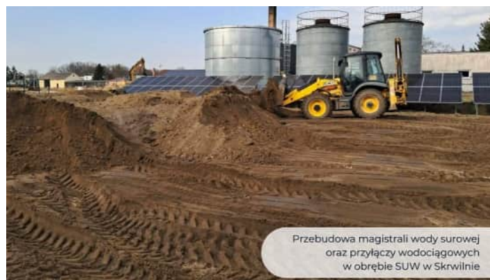
Przebudowa magistrali wody surowej oraz przyłączy wodociągowych w obrębie SUW w Skrwilnie
