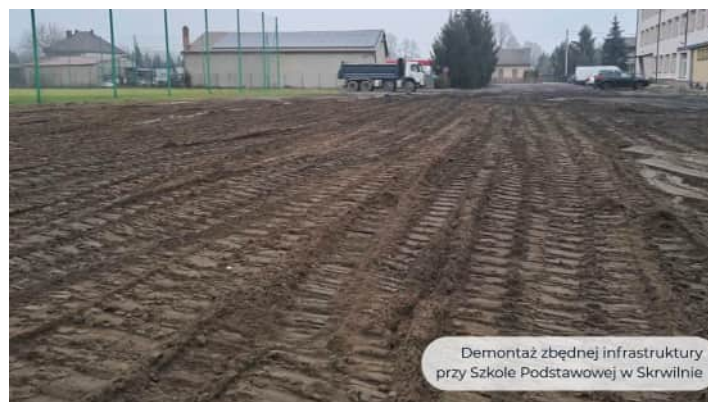
Demontaż zbędnej infrastruktury przy Szkole Podstawowej w Skrwilnie
